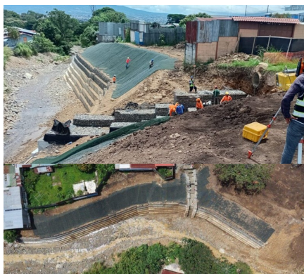
Vistas del proceso constructivo del muro de gaviones
