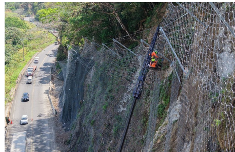
Colocación de la barrera atenuadora
